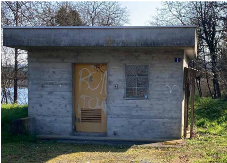
Pumpwerk Aarebrüggli, Felsenau
